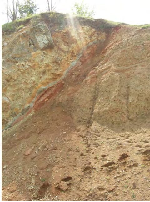
Şekil 5.3. Varto mahallesi tren yolu yarmasında gözlenen K50^{\circ}D,70^{\circ}GD doğrultulu kırık
