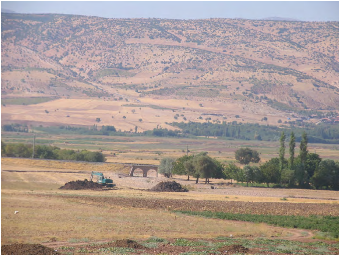
Şekil 5.11. Seğintepe hendeklerinin güneyden görünümü
